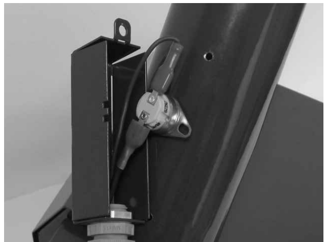
Joonis 10. Kaitsetermostaat graanulite toitetorul, 95 °C
